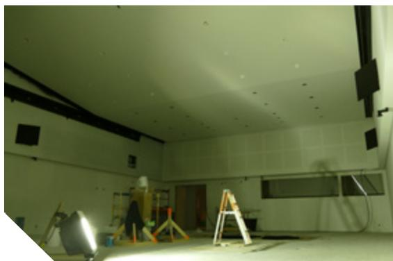
Le gypse sur les murs de la **salle multifonctionnelle** est en place. La construction de l'ossature et la finition électromécanique du plafond sont également terminées.
