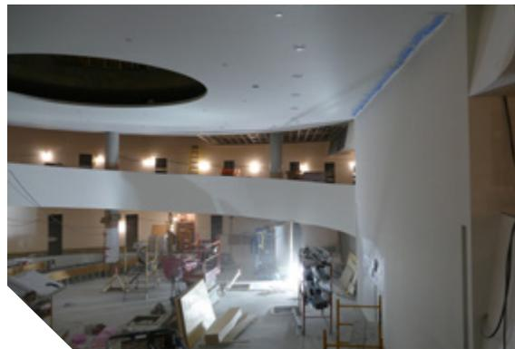
La construction du plafond, dont le tirage de joints est effectué, permet de voir la grosseur et la profondeur de l'oculus. On remarque aussi, grâce au gypse présent sur une bonne partie du garde-corps, l'ouverture progressive de la rampe sur l'agora.
