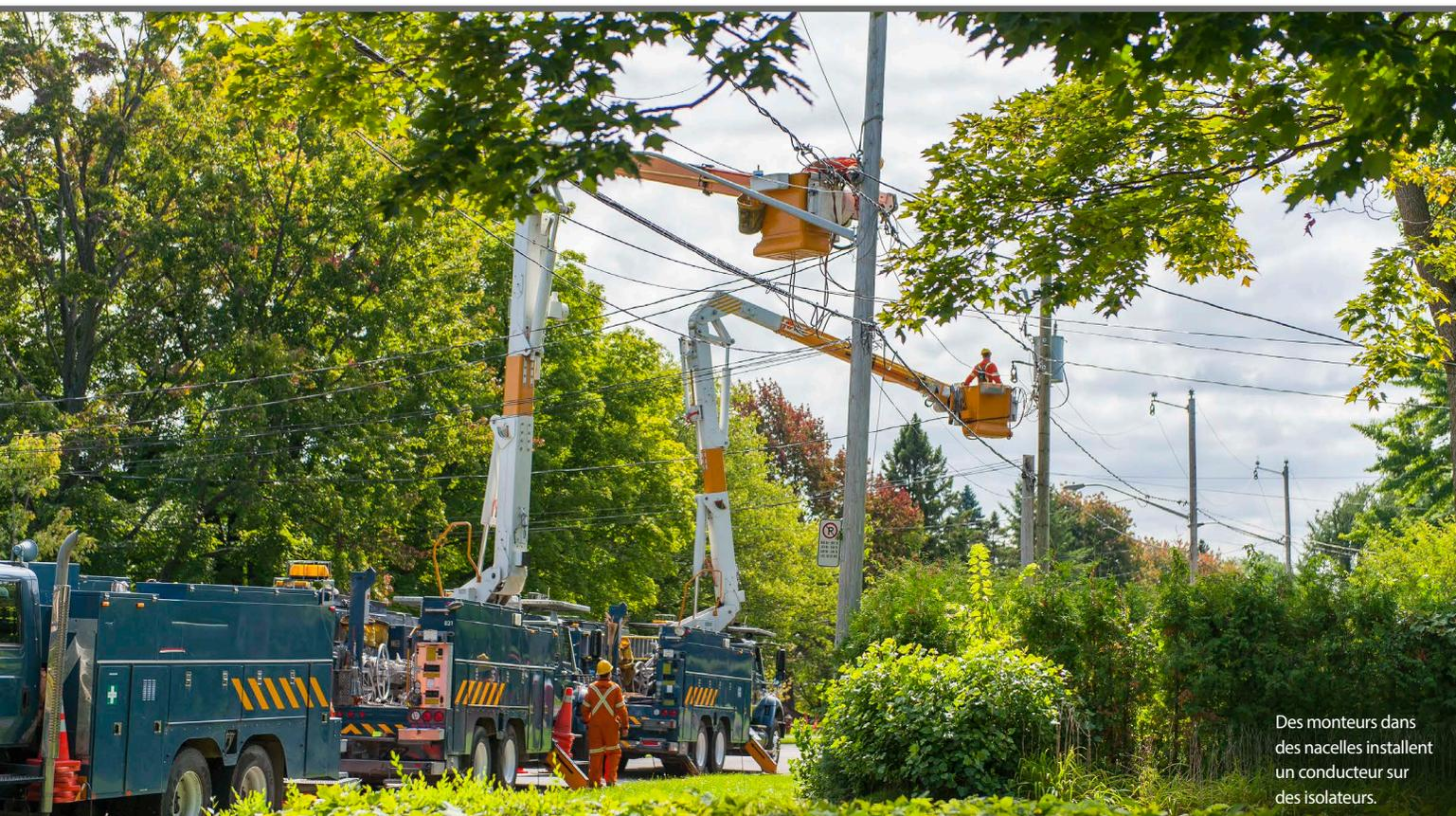
Des monteurs dans des nacelles installent un conducteur sur des isolateurs.
