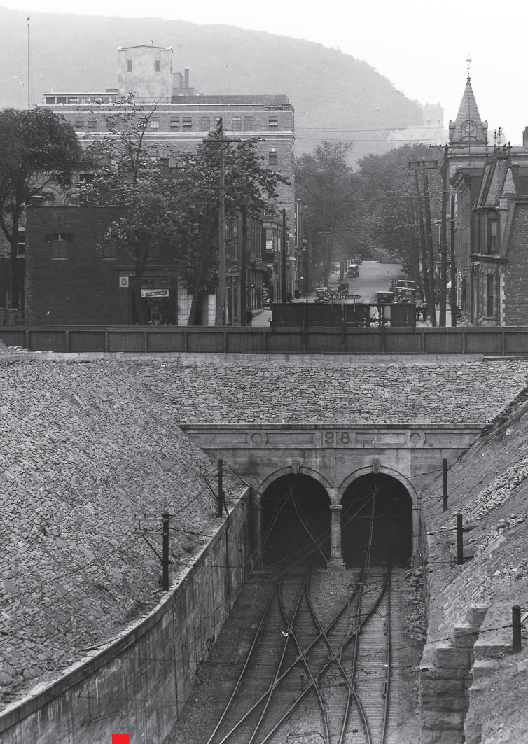
Tunnel du CNR sous le mont Royal, Montréal, QC, 1918 (réf. 3).
