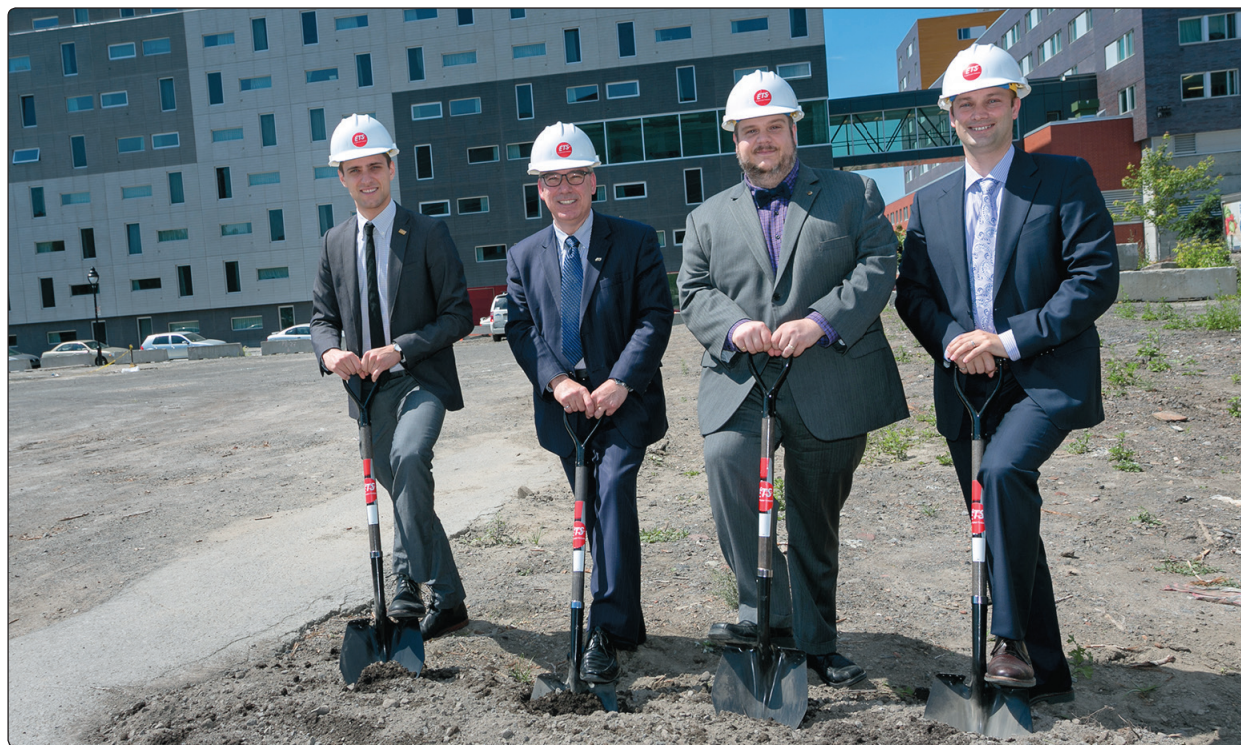
C'est sous un soleil radieux que l'on a procédé, le 21 juin, à une pelletée de terre symbolique en vue de la construction de la Maison des étudiants, annonçant ainsi officiellement le projet. De gauche à droite : Vincent Carignan, président de l'Association des étudiants de l'ÉTS, Yves Beauchamp, alors directeur général de l'ÉTS, Benoît Dorais, maire de l'arrondissement du Sud-Ouest, et Jean Belzile, sous-ministre adjoint (MESRST).
