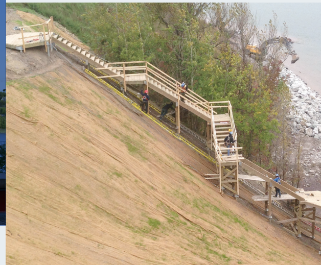
Chantier de l'escalier n° 8 au sentier des Grèves © CCNQ, Larry Tremblay
