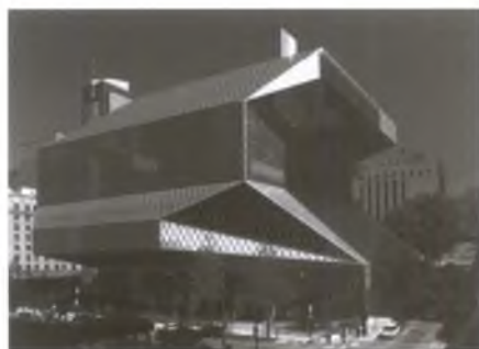
Bibliothèque centrale de Seattle.
