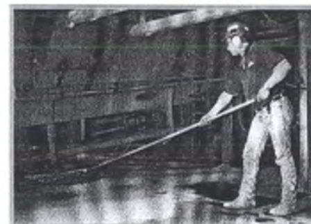
Dans le cadre de la campagne de promotion des réalisations en santé et sécurité au travail, Les Ressources Forestières Doular de Malartic ont présenté cette gralle en aluminium, utilisée pour nettoyer tout les écorceux tout en protégeant le travailleur.
