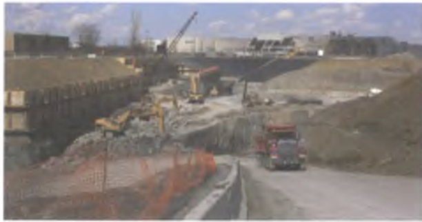
Excavations à la station Montmorency
