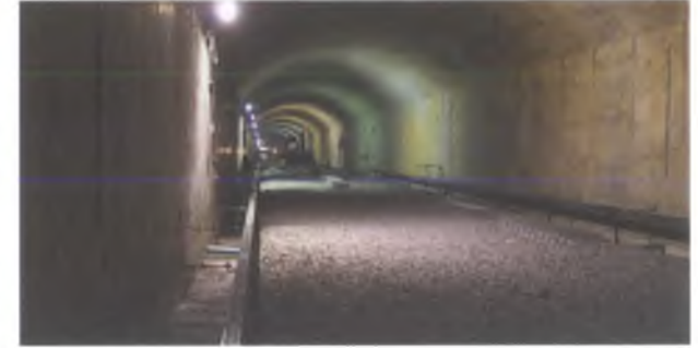
Le Tunnel sous le parc Saint-Claude à Laval
