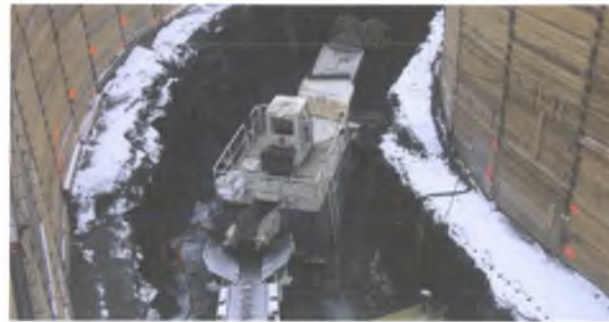
Excavations de la rampe au parc Saint-Claude à Laval
