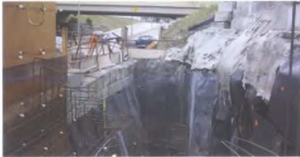
Sortie de secours de la station de la Concorde à Laval
