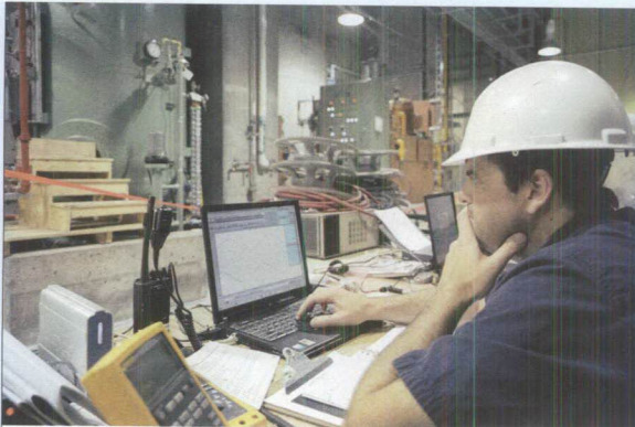
À la centrale de la Toulnostouc, prêt pour la mise en route d'un groupe turbine-alternateur.
