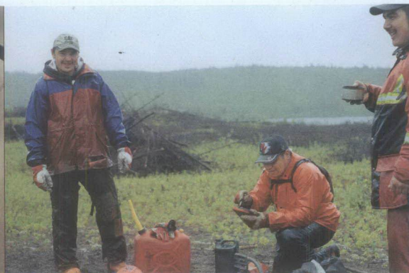
Un effectif de plus de 320 Cris sur le chantier de l'Eastmain-1.
