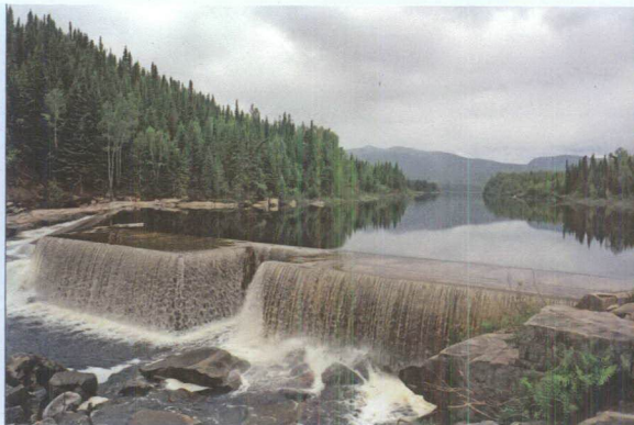
Pour préserver les habitats du poisson, nous construisons des seuils qui rehaussent le niveau des cours d'eau.
