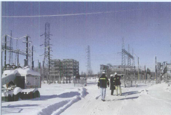
Au poste de Lévis, un déglaceur de lignes à haute tension sera installé.
