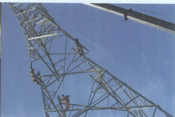
Une ligne à 315 kV relie la centrale de la Toulnostouc et le poste de Micoua.
