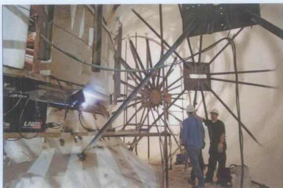
Montage d'une bache spirale à la centrale de l'Eastmain-1.
