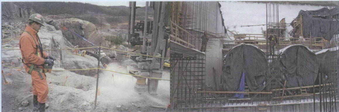
Au site de la centrale de la Péribonka, les travaux de construction vont bon train.
