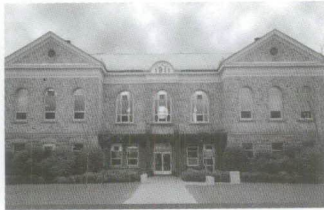
Palais de justice de Mont-Laurier. Photographie : Collection, Société immobilière du Québec.
