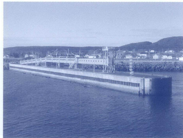
Passerelle de Godbout Photo : Jean-Pierre Boucher
