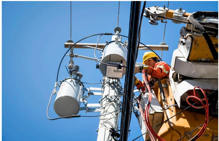
Une monteuse installe le système MILE (maintenance intelligente de lignes électriques) sur une ligne de distribution dans les Laurentides.
