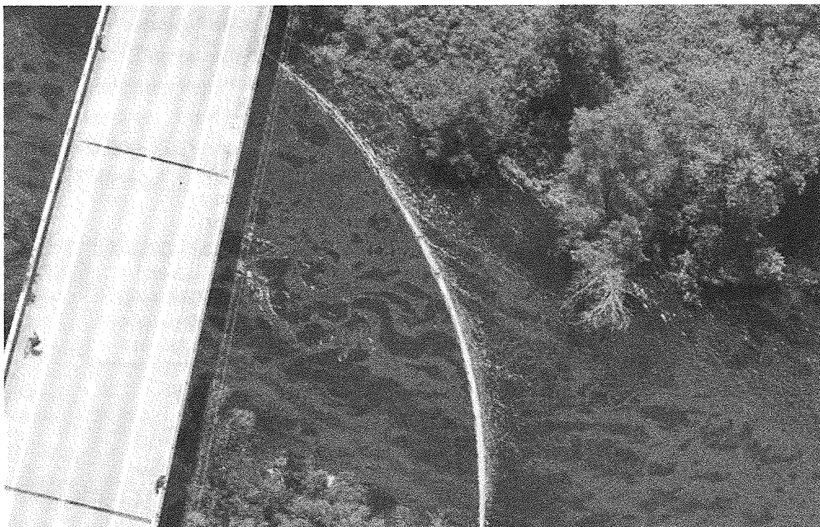
Photo 2 : À 10 km en aval du déversement, les hydrocarbures s'échappent de l'estacade.
