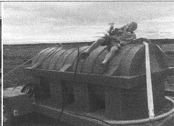
Installation de réservoirs en milieu rural (SarahAnderson CBC)
