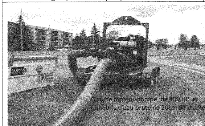
Installation d'un groupe moteur-pompe au km (Kayle Neis)
