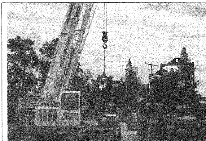
Arrivée de 30 groupes moteur-pompe à Prince-Albert
