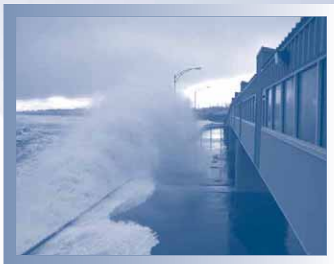
Vagues de forte amplitude frappant le quai de Godbout.
