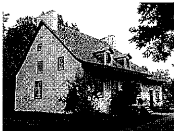
Maison de Saint-Hubert. Vue d'angle Claude Bergeron, © MRC de la Vallée-du-Richelieu
