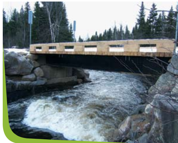
Ce pont dans la Zec de la Jeannotte a été construit à l'été 2006 avec une aide financière du Programme de mise en valeur des ressources du milieu forestier. Il illustre bien l'amélioration des infrastructures du réseau routier forestier.
