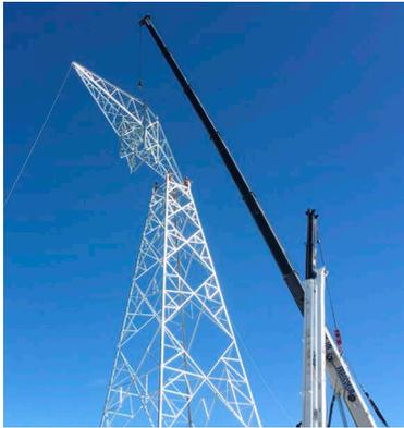
Projet de la Chamouchouane–Bout-de-l'Île : montage du premier pylône de la section 3, au réservoir Taureau, à Saint-Zénon, en Mauricie. Les travaux de construction de la ligne devraient se terminer en 2018.
