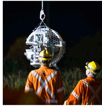
La première phase d'installation de spirales anti-accumulation de verglas a été réalisée sur des lignes de transport qui passent au-dessus d'intersections importantes dans les villes de Québec et de Lévis. Les spirales empêchent l'accumulation de glace sur les conducteurs de lignes à haute tension lors de l'utilisation du système de déglaceage installé au poste de Lévis.
