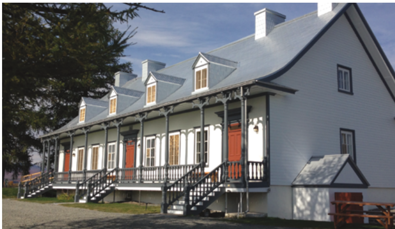
Restauration de la Grande-Ferme de Saint-Joachim – classée immeuble patrimonial – dans le cadre du programme Aide aux immobilisations © MCC
