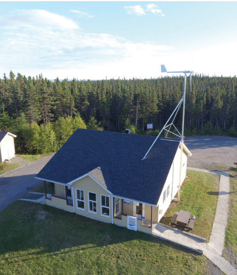
Bâtiment d'accueil touristique situé à Rivière-au-Tonnerre. Photo : Nova-Pro Développement
