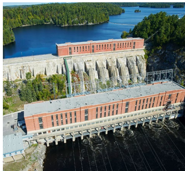
La centrale de Paugan (226 MW), située sur la rivière Gatineau non loin de la municipalité de Low, en Outaouais, est en exploitation depuis 1928, soit 90 ans ! Sa longévité témoigne du soin que nous apportons à la pérennisation de nos équipements de production.
