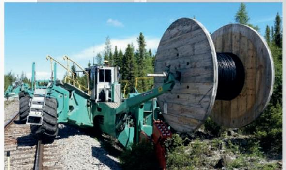
Photo : Installation d'un câble de fibre optique
