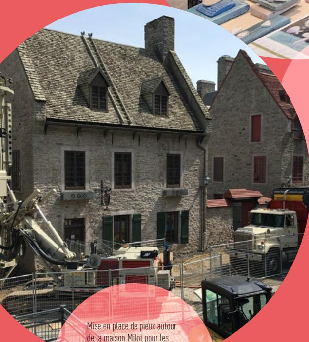
Mise en place de pieux autour de la maison Milot pour les travaux d'imperméabilisation des fondations dans le cadre du projet de réhabilitation et de rénovation des maisons Dumont - Le Picart et Milot à Place-Royale
