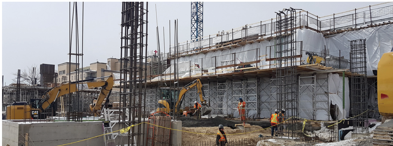
Chantier du nouveau pavillon de soins en santé mentale, Saint-Jérôme
