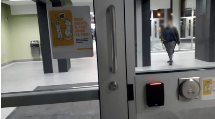
Figure 6 Un lecteur de cartes magnétiques installé sur la porte d'entrée permet de contrôler l'accès aux résidences étudiantes et de le réserver aux personnes qui y habitent et à leurs invités.
