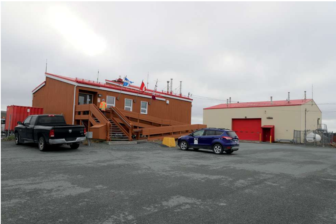
ᐅᓯᐅᓂᓐ ᓯᓐᓴᓴᓐ. Umiujaq Airport. Aéroport d'Umiujaq.
