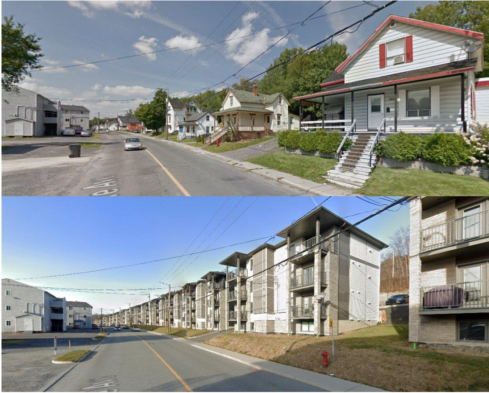
Saint-Georges (2013-2021.) Un exemple de projet densification peu intégré au cadre patrimonial et urbain. Photo : Google. Montage : G. St-Jean
