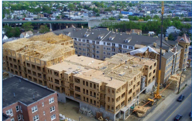
Un édifice en construction au Connecticut.
