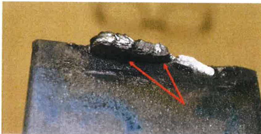
Figure 15 – Partie en compression, exemple de concentrateurs de contraintes (flèches rouges)
