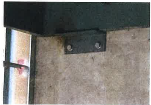
Figure 6 — Exemple d'un angle de soutien installé sous le palier intermédiaire
