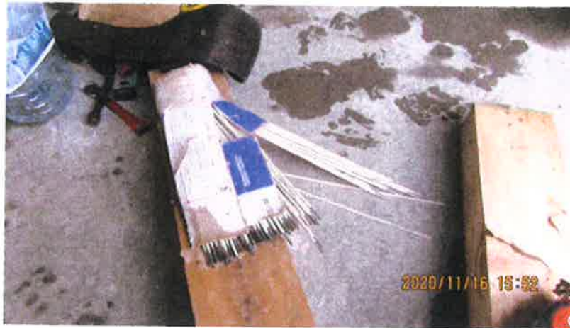
Figure 32 — Photo des électrodes E6011 retrouvées au chantier Source : CNESST
