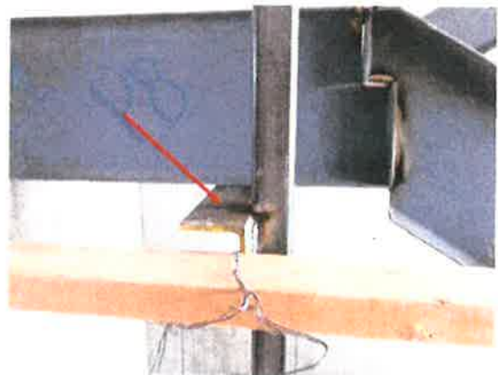
Figure 10 — Exemple d'un angle de soutien temporaire installé sur une colonne de soutien
