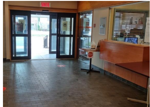
28-07-2022 : Panne de la porte d'entrée. Crédit : Mercédeez Roberge.
