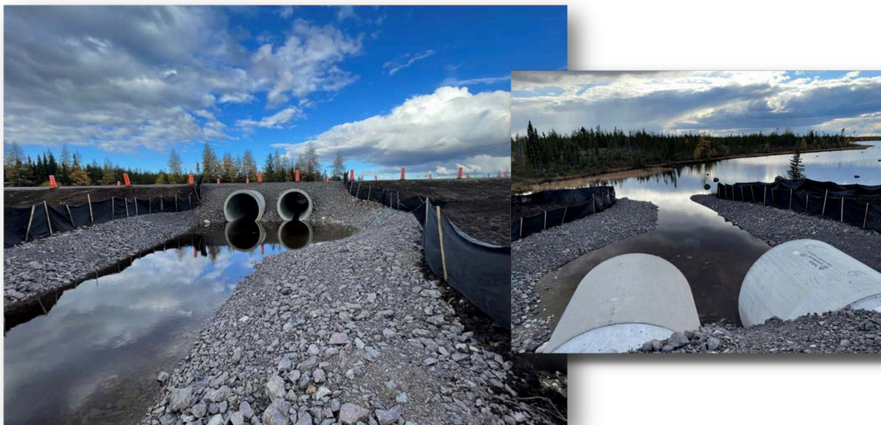
Réalisation de ponceaux complexes au km 512 sur la route Billy-Diamond
