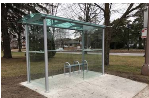
Abribus au coin de la rue Saint-Pierre Sud et du boulevard Manseau, en face de la bibliothèque Rina-Lasnier
