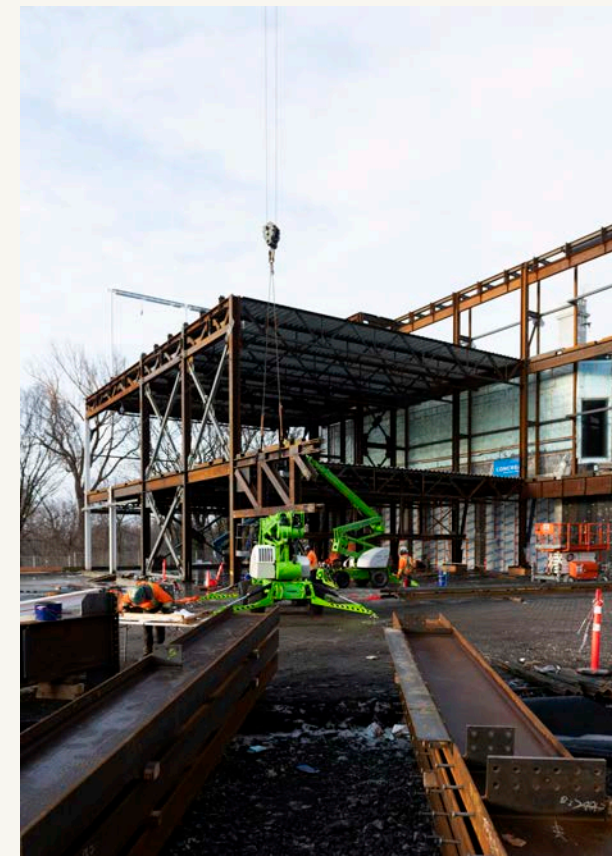
Structure d'acier du nouveau pavillon visible dès mars 2025.
