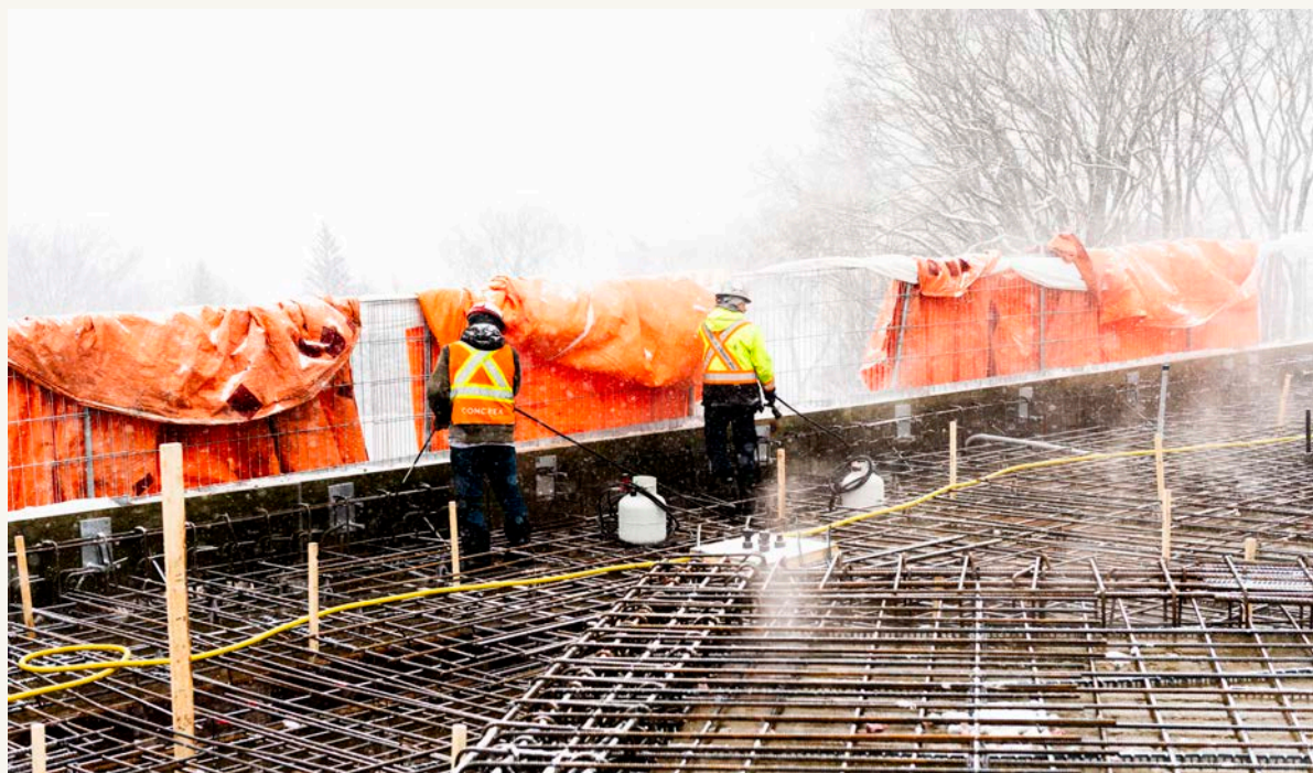
Coulée de la dalle structurale dans des conditions hivernales contraignantes.
