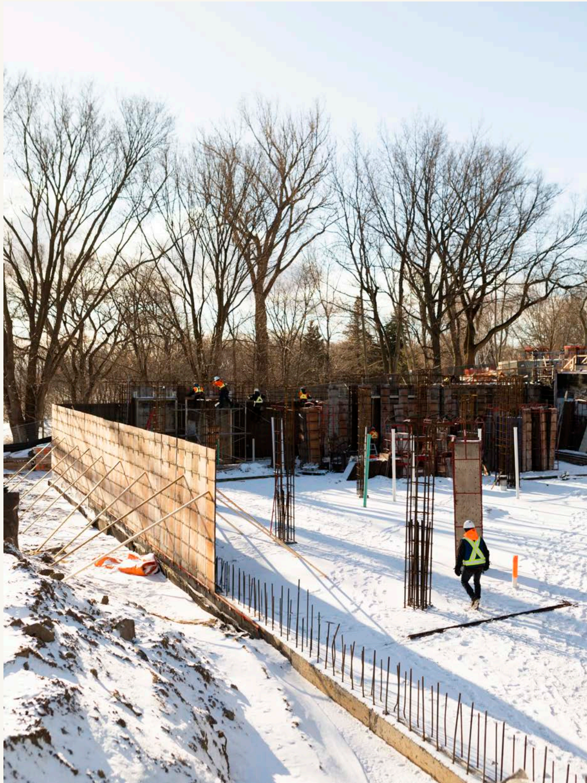
Délimitation du futur bâtiment.
