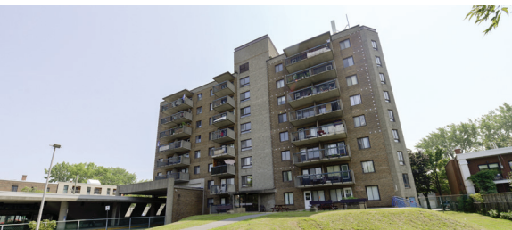
Avant la rénovation des Habitations Charlevoix
