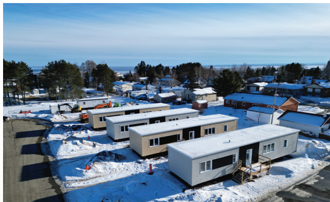
Maisons unimodulaires à Maria pour loger des travailleuses et des travailleurs de la santé
