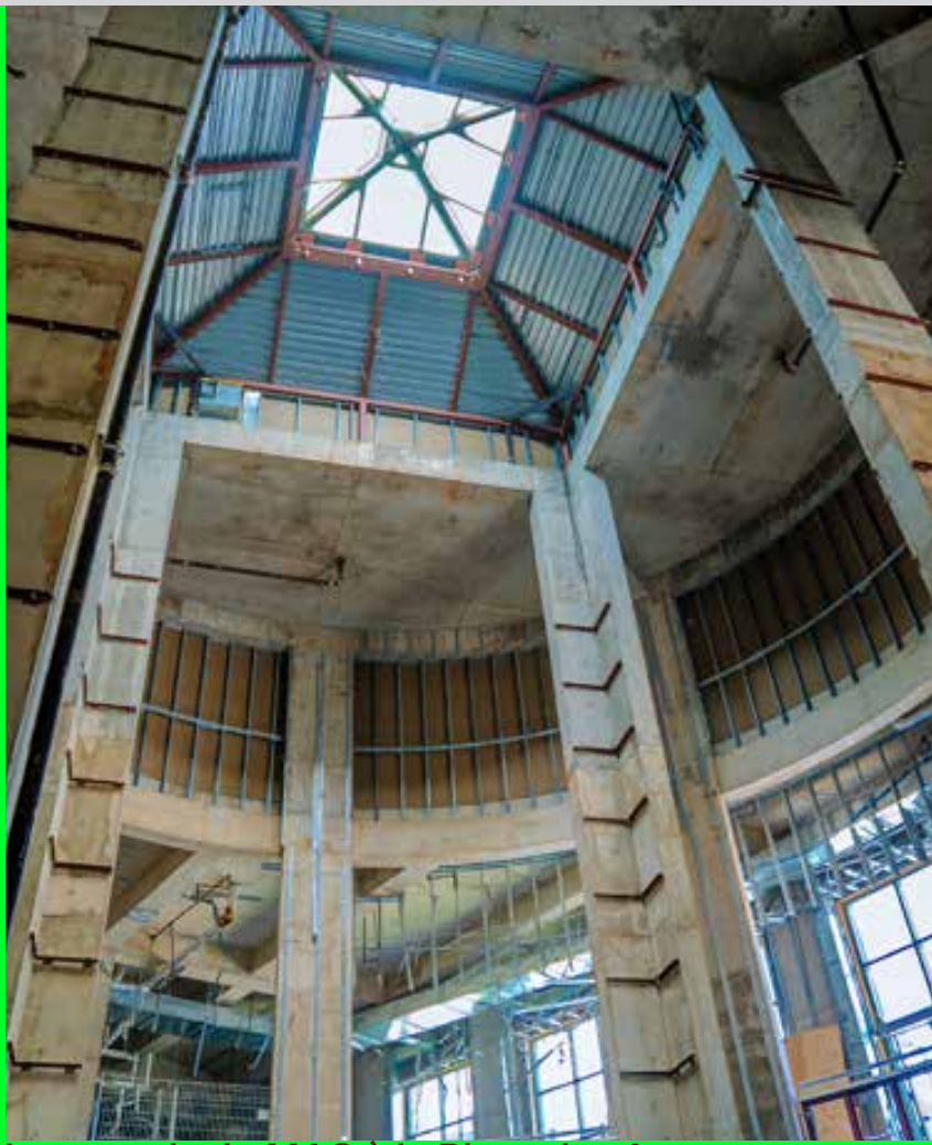
La rotonde du MAC à la Place des Arts en cours de démolition.
