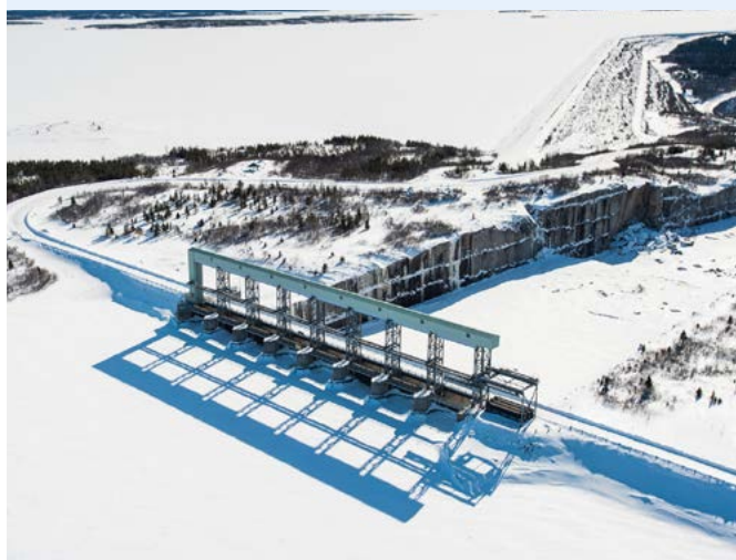
L'aménagement Robert-Bourassa, la plus importante installation de production d'électricité de l'Amérique du Nord.
