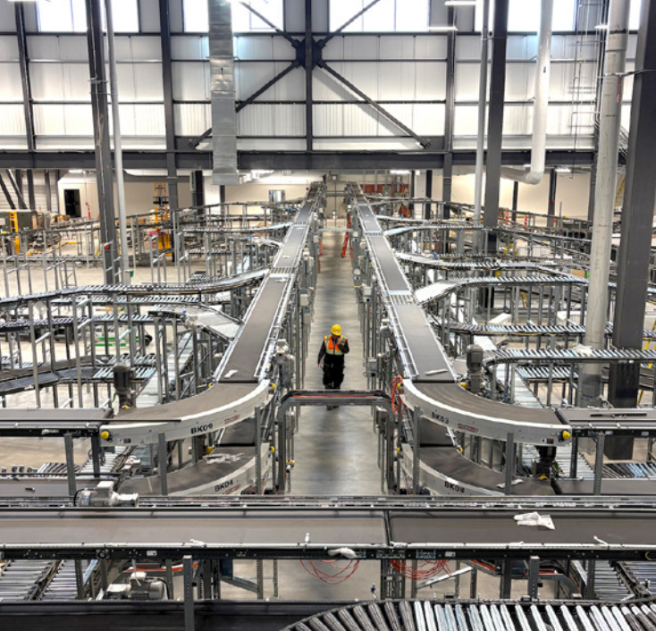
Centre de distribution automatisé, novembre 2025
