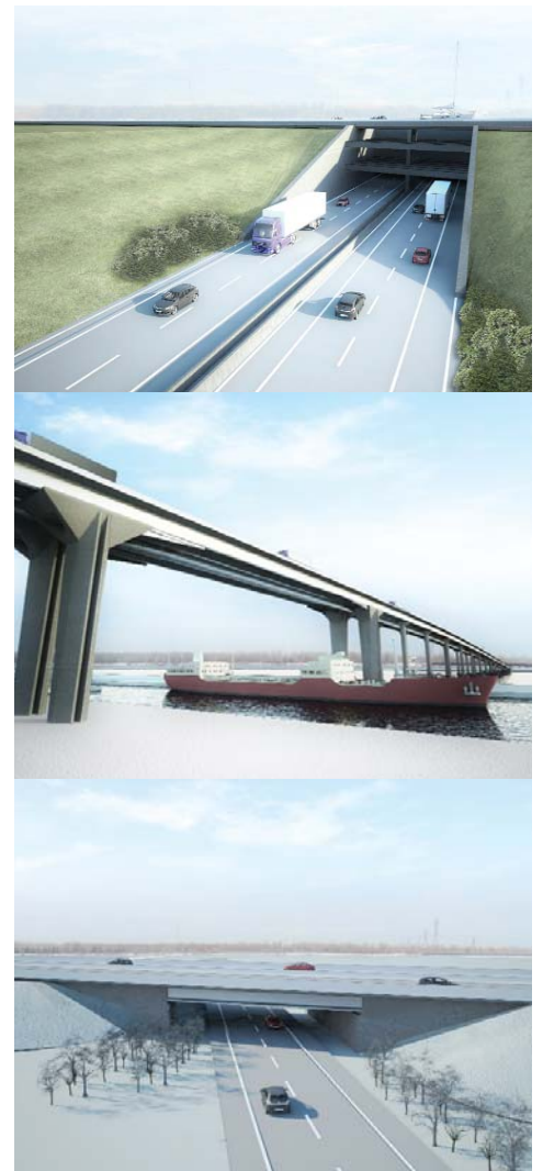
PROJETS DE TUNNEL, DE PONT ET DE VIADUC POUR L'AUTOROUTE 30 I GRACIEUSETÉ DE NOUVELLE AUTOROUTE 30
