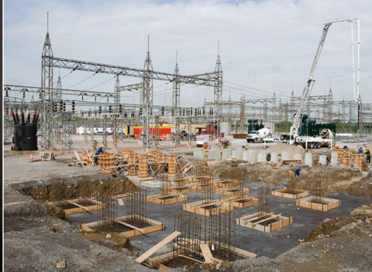
Travaux d'agrandissement du poste de Saraguay, à Montréal, qui ont été menés à bien en 2009.
