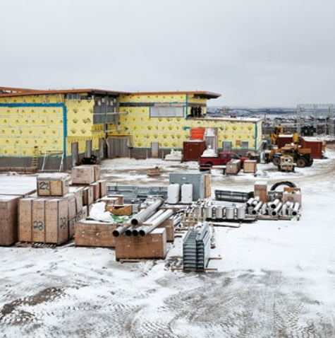
Construction d'une nouvelle centrale à Kuujuaq, au Nunavik, en remplacement de la centrale existante, devenue désuète.
