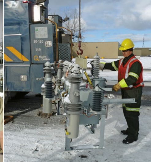
À Granby, en Montérégie, le monteur Benoit Ouellette s'apprête à installer une batterie de condensateurs dans le cadre du projet Addition 1 000 Mvar. L'objectif : assurer la fiabilité du réseau de transport en cas de pointe exceptionnelle.
