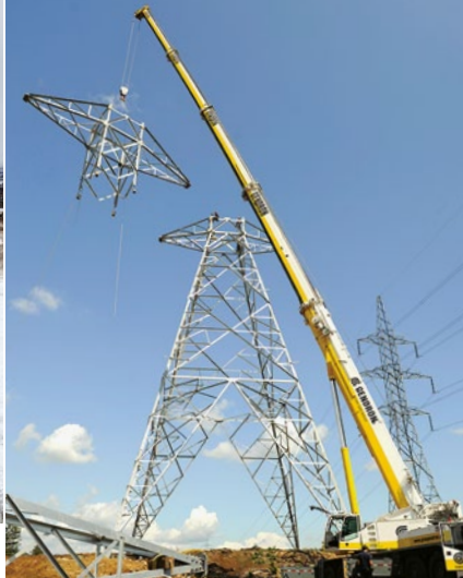
Construction de la ligne Chénier-Outaouais, qui renforcera le poste de l'Outaouais et sécurisera l'alimentation de la région.
