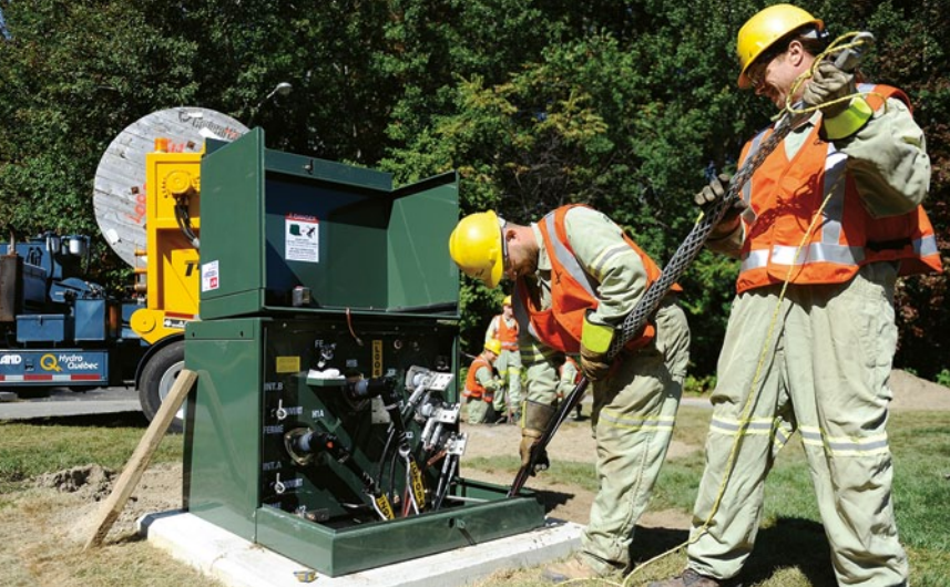
Travaux de réfection sur le réseau de distribution souterrain à Lorraine, dans les Laurentides. Frédéric Vincent, jointeur, et Richard L. Robert, chef jointeur.
