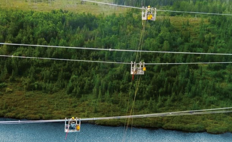
Installation d'entretoises interphases sur la ligne de l'Eastmain-1–Nemiscau, à la Baie-James. Ces dispositifs maintiennent un écartement constant entre les conducteurs et aident à contrer le galop sur les lignes de transport.
