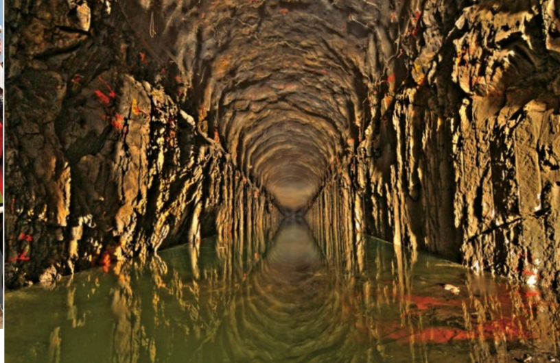
Le tunnel de transfert reliant les biefs Rupert amont et aval, avant la mise en eau des biefs.
