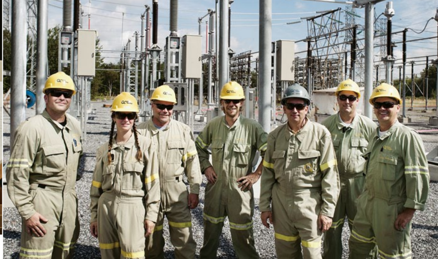
Réfection du poste de Sorel, en Montérégie. Michel Archambault, Chantal Findlay, Claude Turcotte, Martin Trottier, Yves Hardy, Christian Reid et Léodore Thibeault de l'unité Installations de transport – Richelieu.
