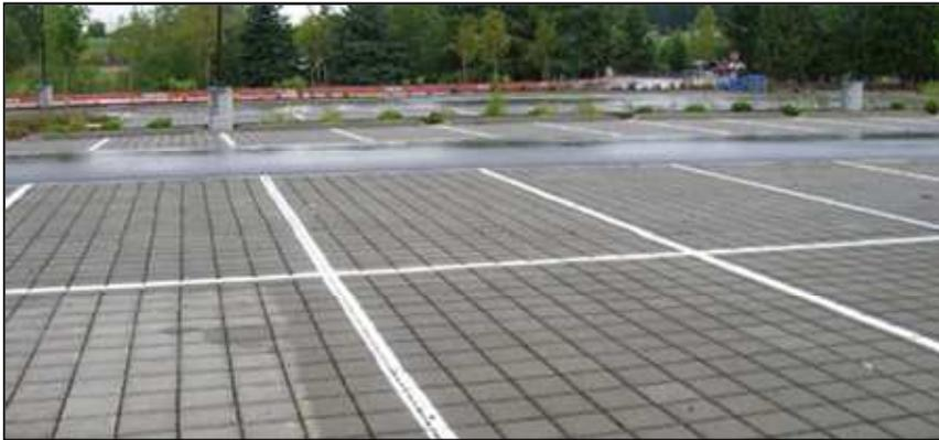
Figure 5 - Pavé perméable
