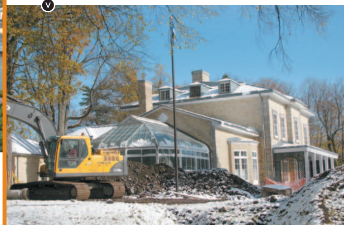
Chantier de revitalisation du domaine Catarauqui © CCNQ, Anne-Marie Gauthier
