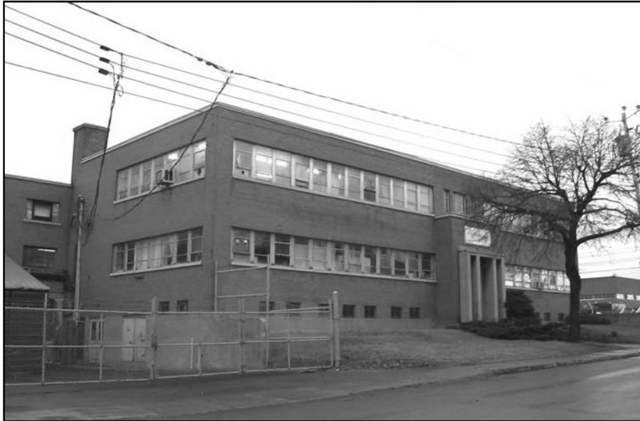
Photo B12 Vue du bâtiment principal occupé par les bureaux administratifs (8355)
