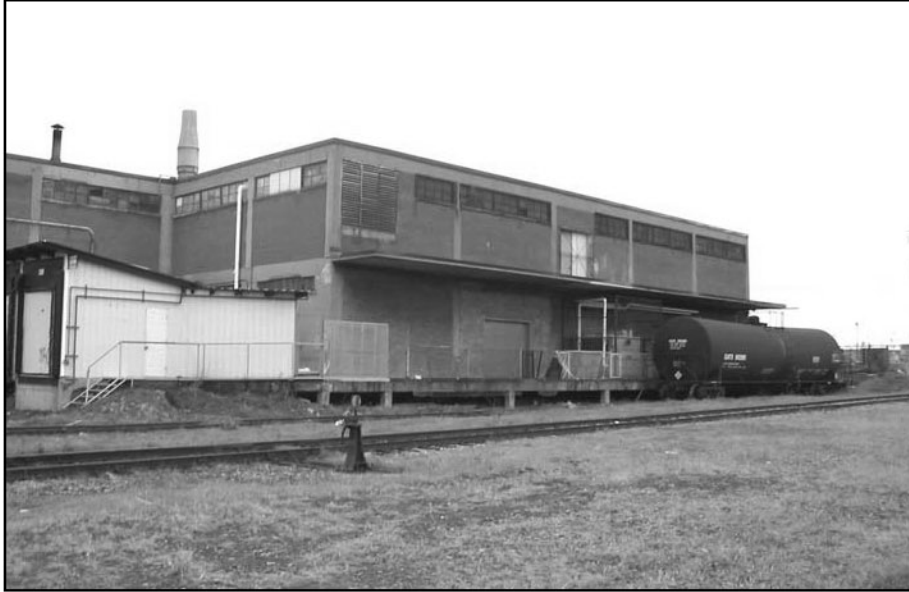
Photo B14 Vue de l'aire de déchargement des wagons-citernes
