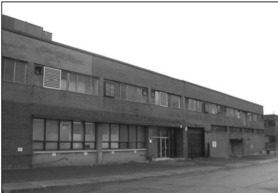
Photo B13 Vue du bâtiment de fabrication et d'entreposage (8350)
