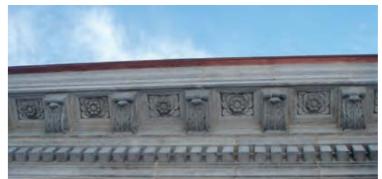
La corniche de l'édifice André-Laurendeau après sa restauration
