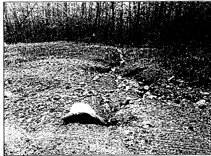
Figure 15 : Ponceau ouvert sur la route d'accès au mont Orford
