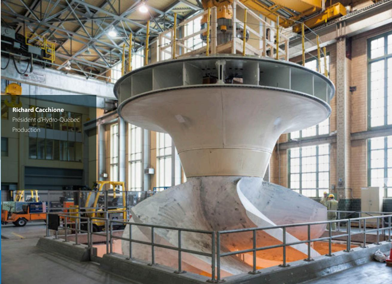
Mise en place de la roue d'un groupe turbine-alternateur de la centrale de Beauharnois. Sa localisation stratégique permet d'alimenter simultanément, s'il le faut, la charge locale et les réseaux de l'Ontario et de New York.
