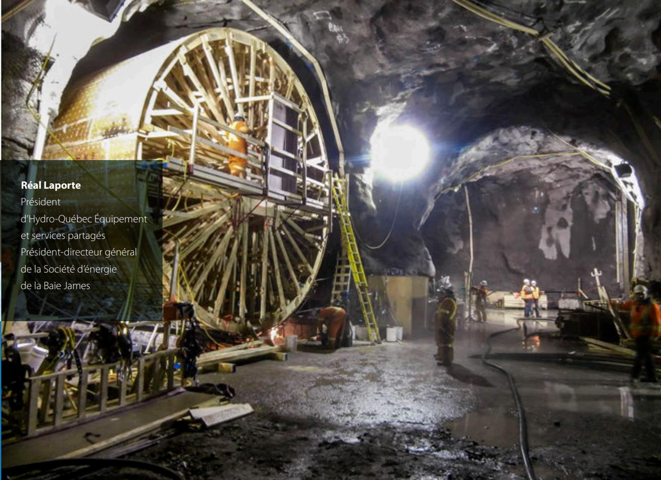
Coffrage de la transition inférieure de la conduite forcée d'un groupe turbine-alternateur de l'aménagement de la Romaine-1.
