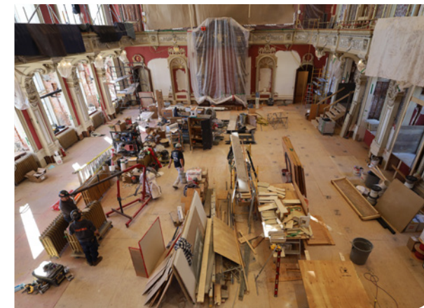
Images des travaux dans la salle du Conseil législatif
