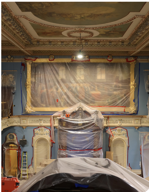
Travaux dans la salle de l'Assemblée nationale.
