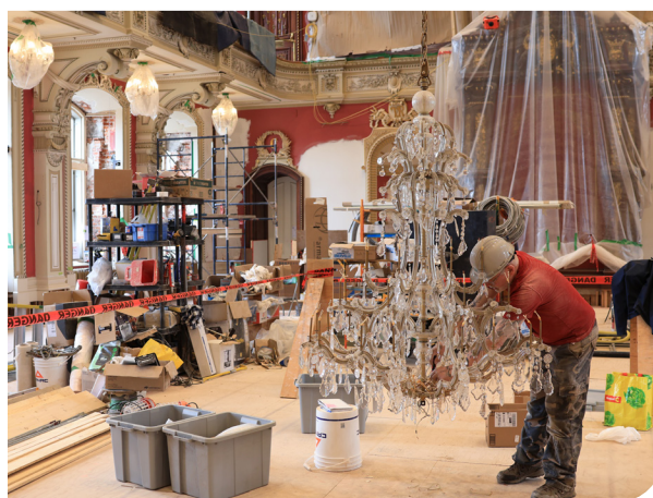
Travaux dans la salle du Conseil législatif.
